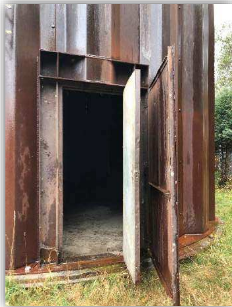
AE- 123 Tower door
